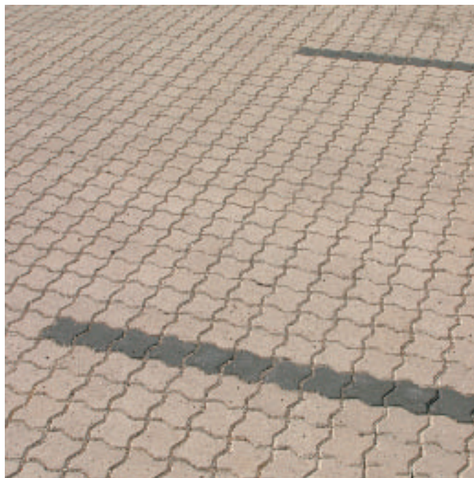
■ Wewers Unilock leveres i store læggeenheder á ca. 0,9 m 2 pr. lag i 8 og 10 cm's tykkelse.
